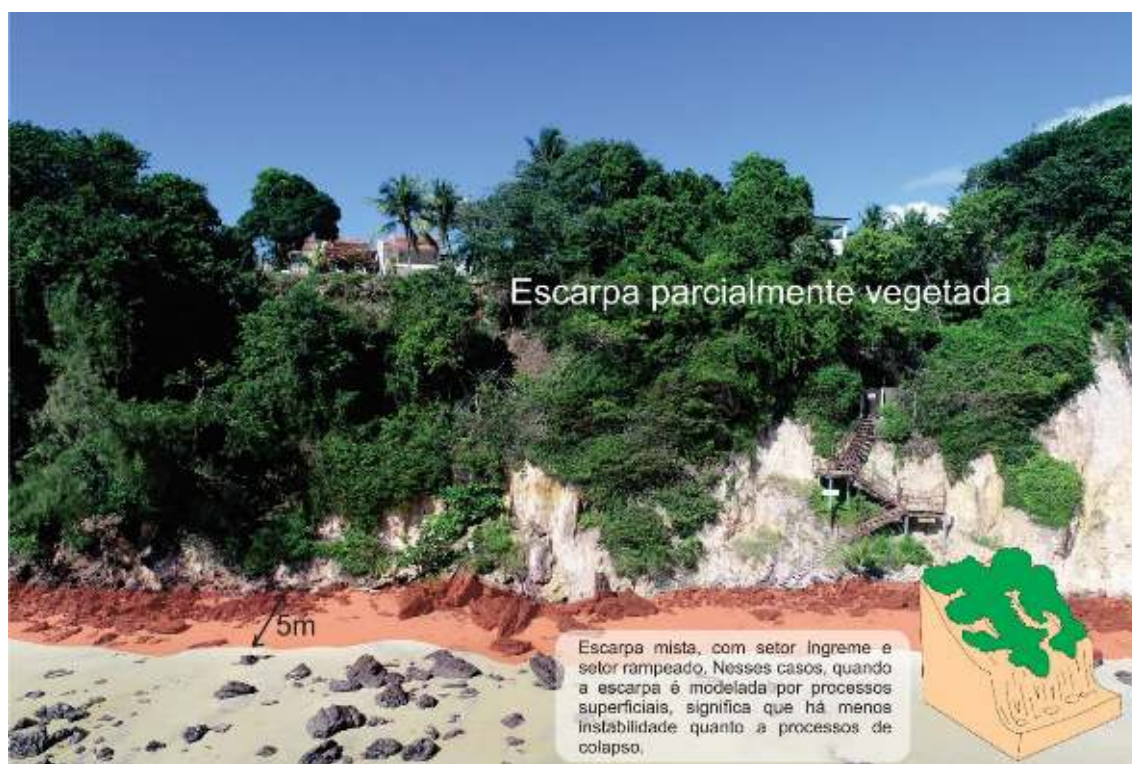
Figura 80: Trecho 3 – Falésia parcialmente vegetada.
