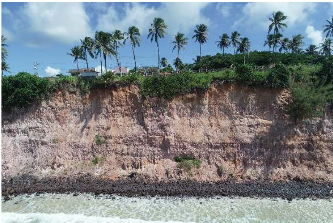
Figura 11: Características estratigráficas da área onde foram executados os levantamentos com GPR (perfis 10 e 13) e Gama Ray.
