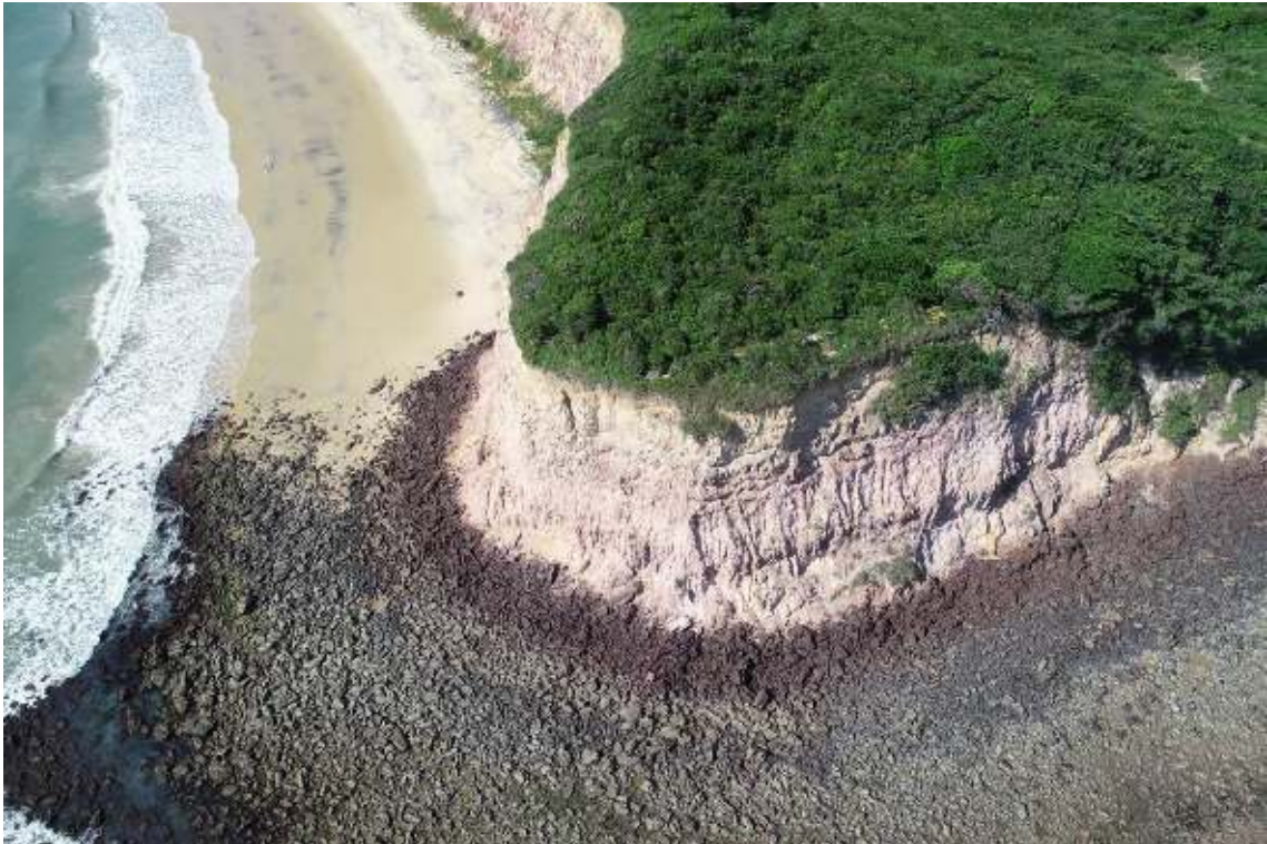
Figura 39: Foto do promontório que divide Baía dos Golfinhos e a praia do Madero. Densa ocorrência de blocos de laterita protegem a base do promontório litorâneo.
