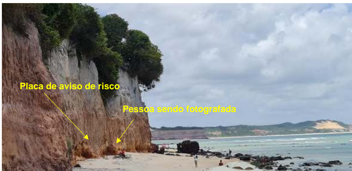
Figura 90: Pessoa posando para foto ao lado de placa indicativa de risco.
