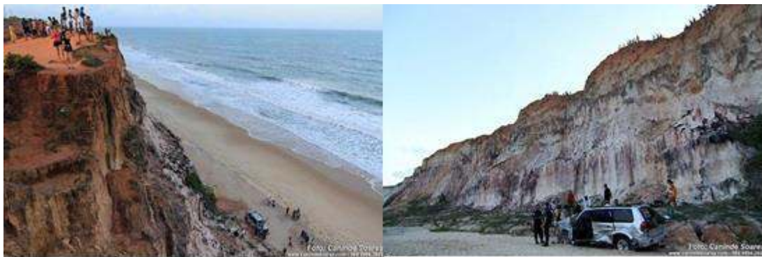
Figura 88: Fotos do acidente ocorrido em março de 2012.
