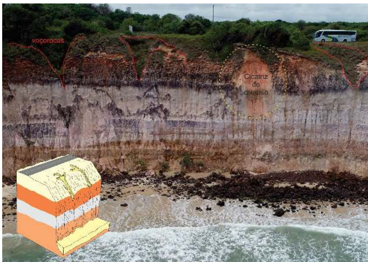
Figura 24: Voçorocas as margens da RN063.
