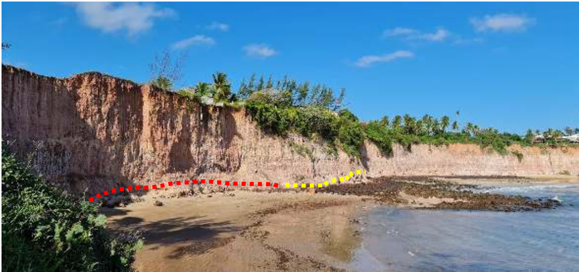
Figura 102: Evidência da proteção contra a erosão em função do depósito de talus. A linha vermelha mostra a área onde as ondas atingem diretamente à base da falésia, em contraste com a área da linha amarela onde parte da energia das ondas é dissipada nos blocos de laterita.
